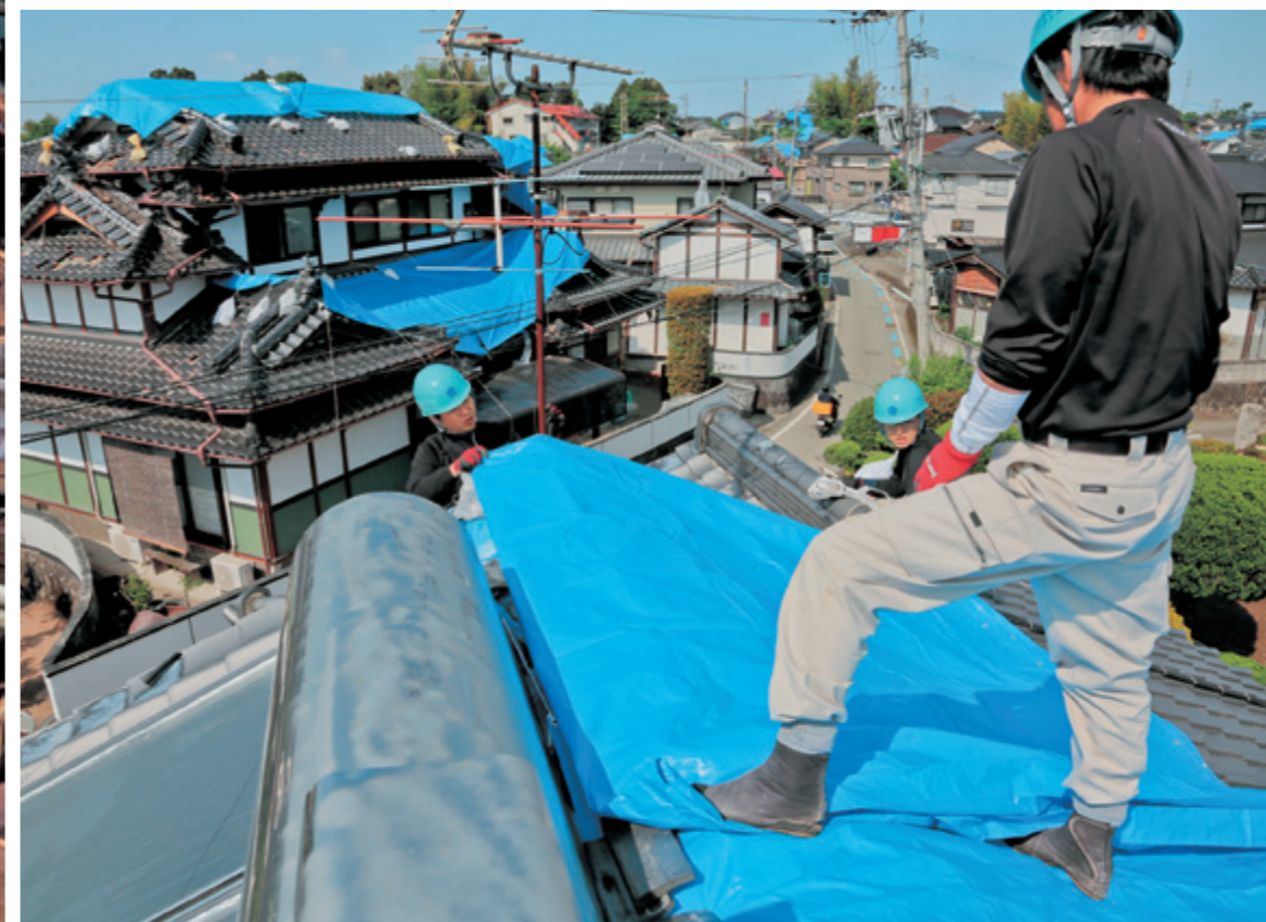
瓦が欠落した屋根にブルーシートを張る隊員たち（5月4日、同）
