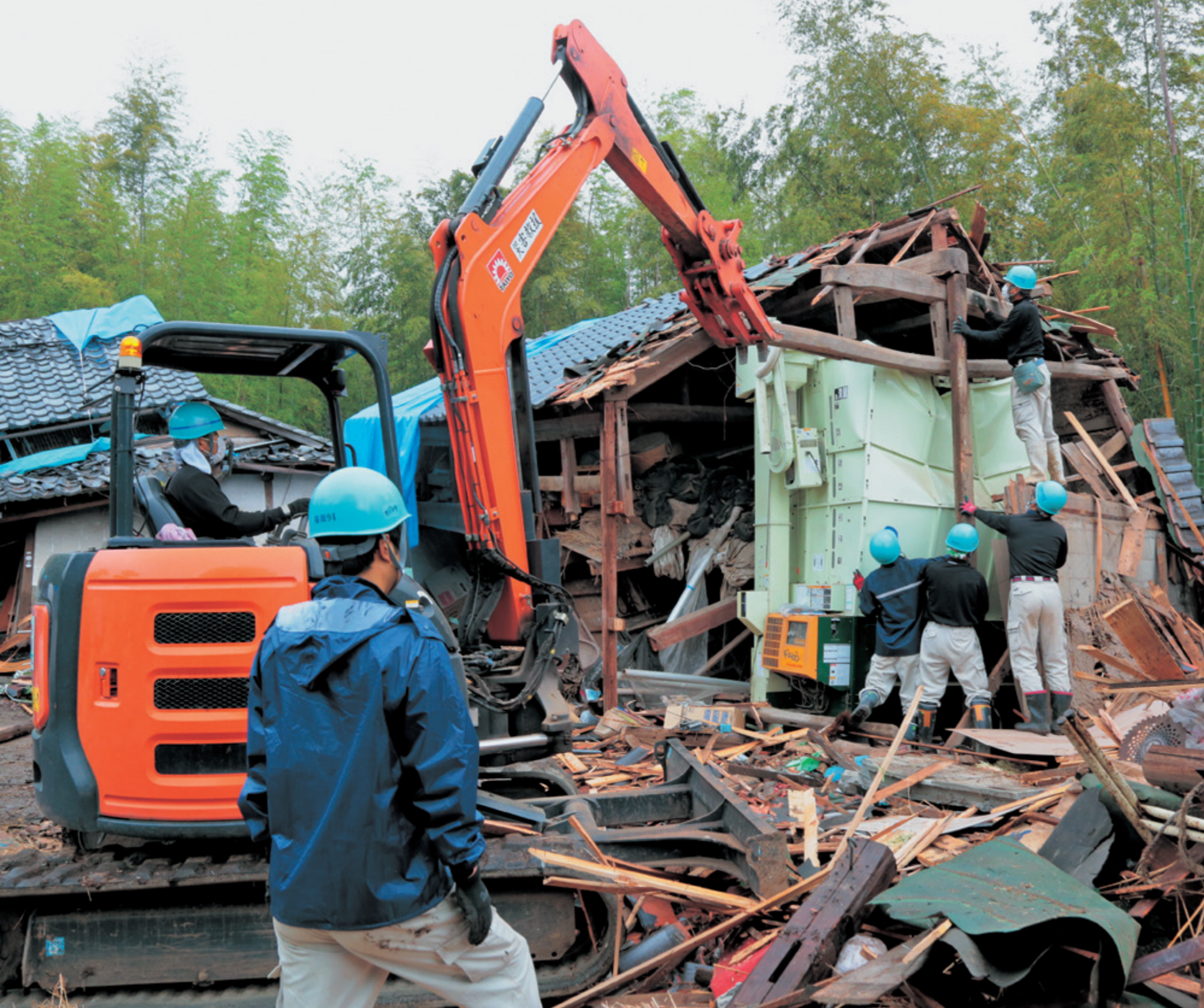
倒壊した納屋から農機具を取り出す作業を引き受けた（5月9日、熊本県益城町で）
